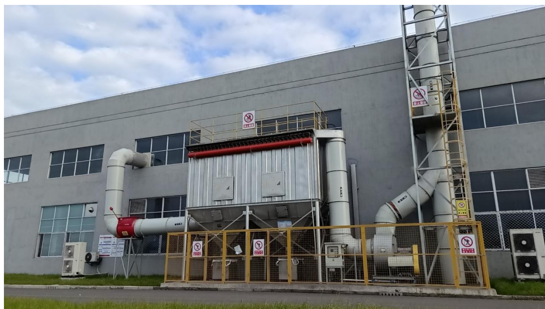
图 3-5 烧结、磁选、打磨废气处理设施
