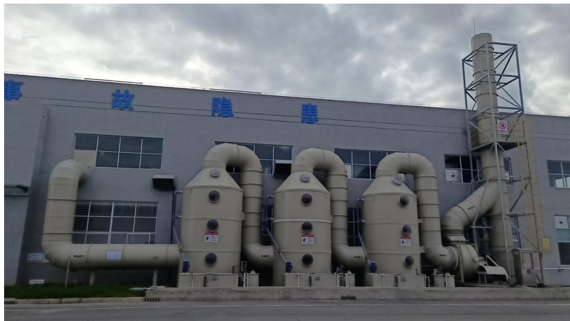
图 3-7 浸泡、酸洗废气处理设施
